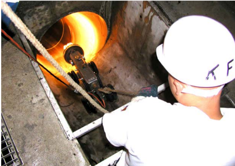
Reinigungsarbeiten im Kanalnetz: Die Dokumentation sämtlicher Maßnahmen wird mittels spezieller Tiefbau-Lösungen und Fachschalen festgehalten.
